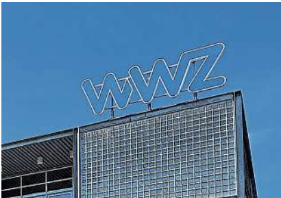
WWZ ersetzt alte Leitungen.
